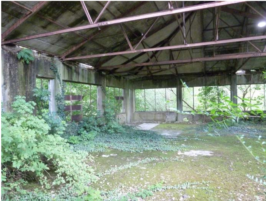
Rohbau ruine „Gummifabrik“
